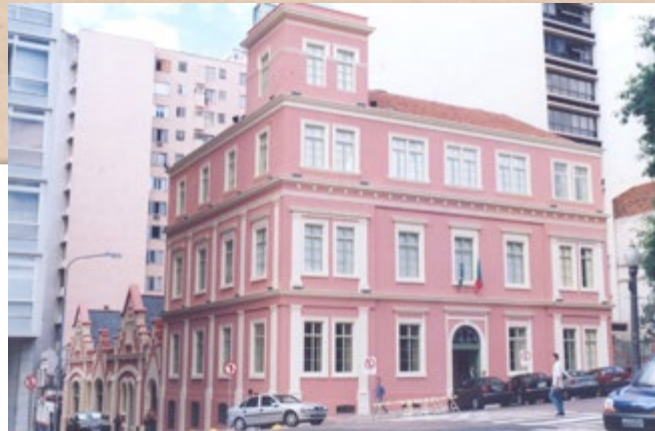
Em 2002, foram concluídas as mais recentes obras de restauração do prédio, que desde novembro de 1986 tem seu tombamento histórico ratificado. Foto: Memorial MPRS/Divulgação
